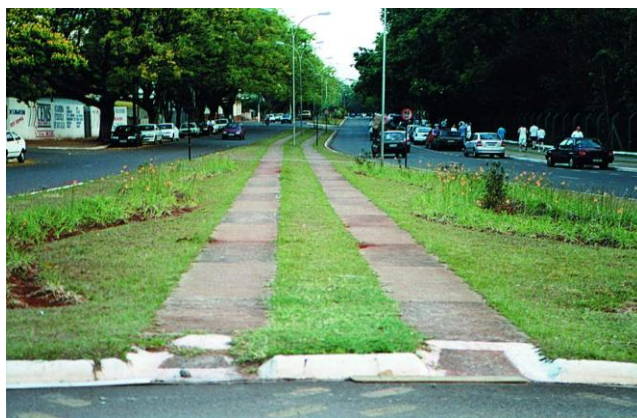
FIGURA 68 CICLOVIA NO CANTEIRO CENTRAL DA AV. CONTORNO DO PARQUE DO INGÁ
