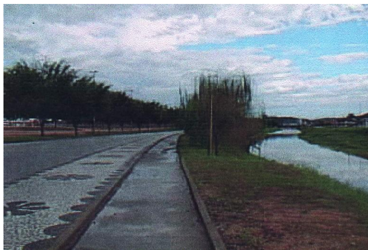
FIGURA 94 CICLOVIA IMPLANTADA ÀS MARGENS DO RIO ITAJAÍ-MIRIM
