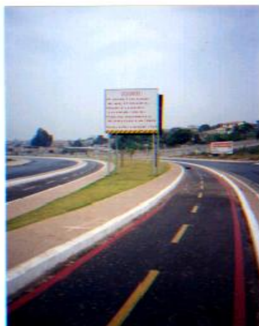
FIGURA 130 PAVIMENTO E SINALIZAÇÃO DE CICLOVIA NO CANTEIRO CENTRAL DE RODOVIA
