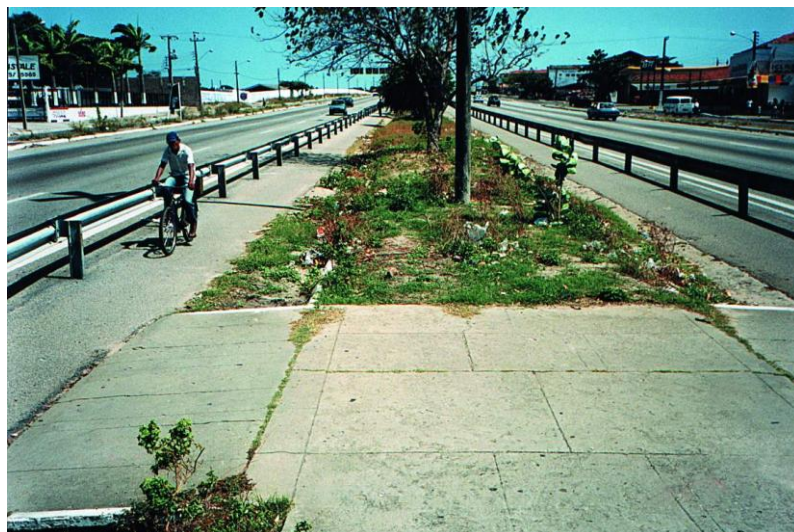
FIGURA 102 CICLOVIA NO CANTEIRO CENTRAL DA BR-116
