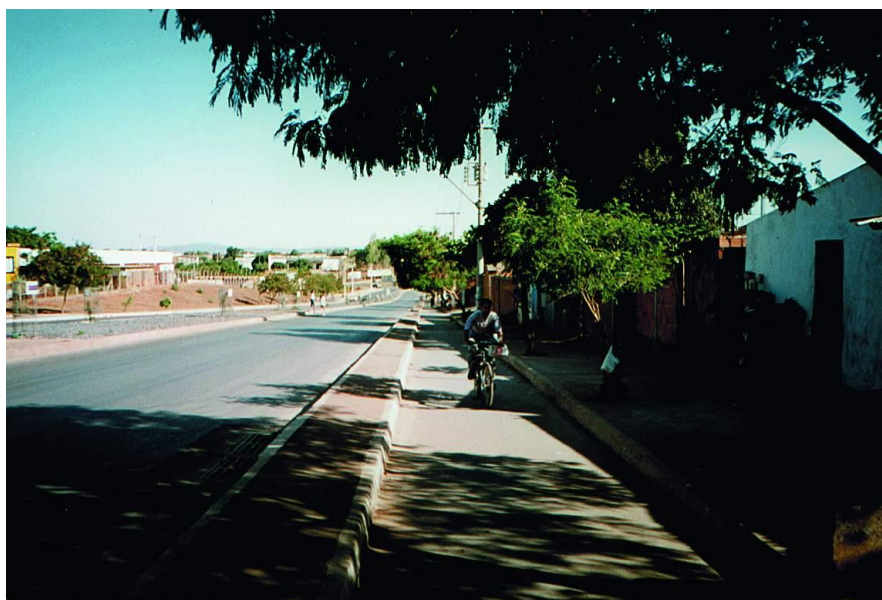
FIGURA 140 CICLOVIA EM BAIRRO DA PERIFERIA DA CIDADE
