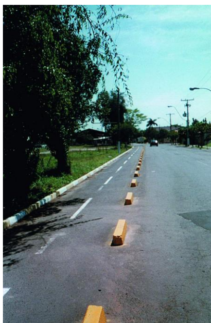
FIGURA 84 USO DE BLOCO DE CONCRETO COMO SEPARADOR DA CICLOFAIXA
