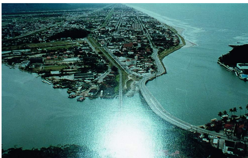
FIGURA 38 VISTA AÉREA DA ÁREA URBANA DO MUNICÍPIO
