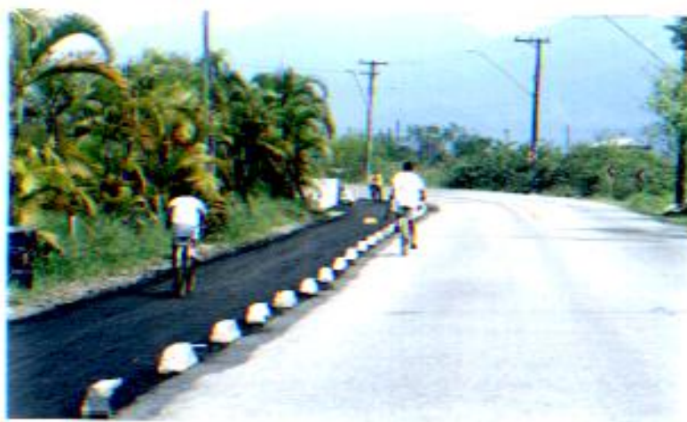
FIGURA 32 CICLOVIA JARDIM CASQUEIRO/CARAGUATÁ, COM CICLISTAS DENTRO E FORA DA PISTA
