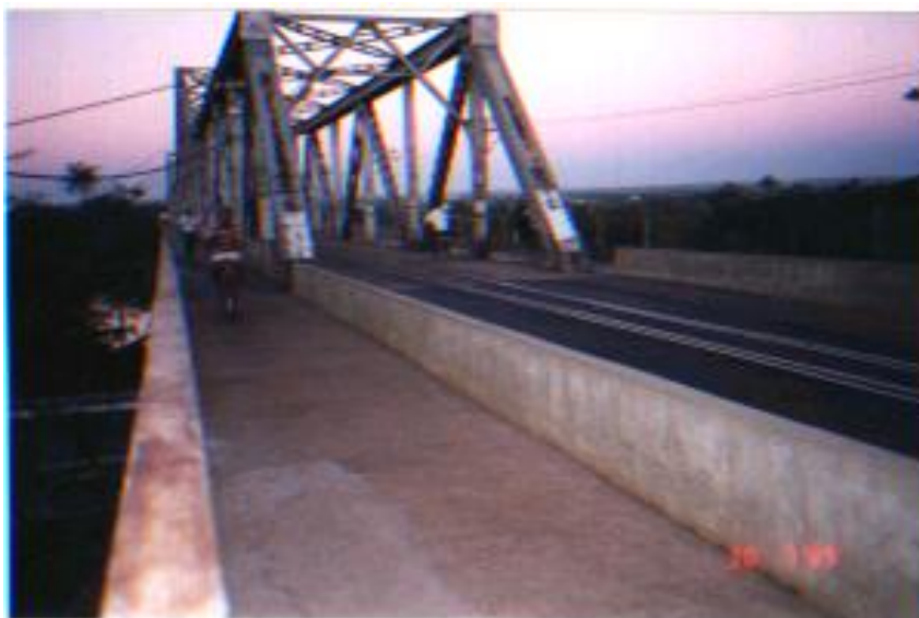
FIGURA 126 PASSARELA DE CICLISTAS E PEDESTRES, NA PONTE JOÃO LUÍS FERREIRA
