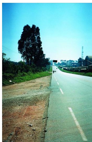
FIGURA 65 AV. DAS ARAUCÁRIAS, DE GRANDE CIRCULAÇÃO DE CICLISTAS
