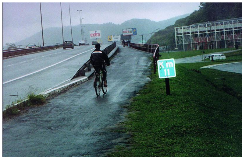
FIGURA 45 VIADUTO ATRIBUNA, ALARGADO PARA CICLISTAS
