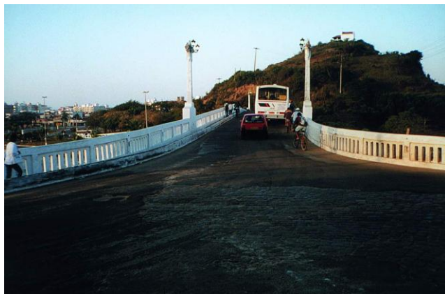
FIGURA 18 CICLISTAS NA PONTE FELICIANO SODRÉ
