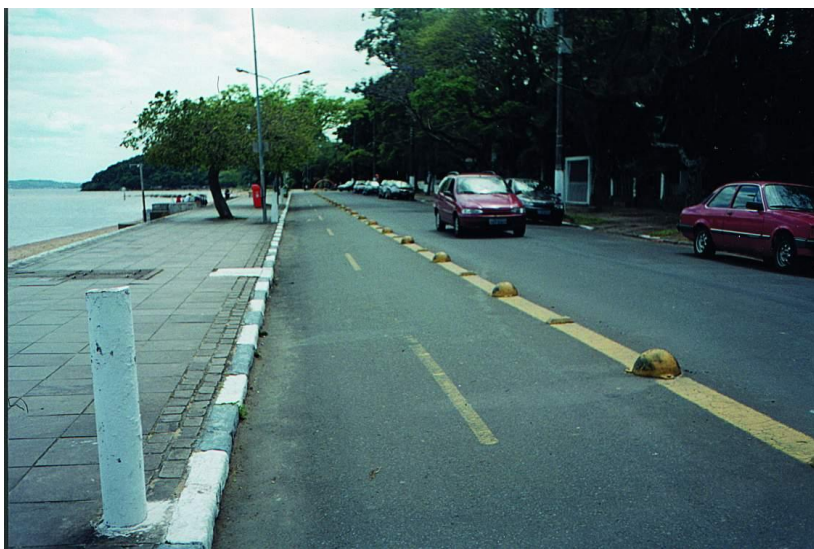
FIGURA 76 CICLOFAIXA NA ORLA DO RIO GUAÍBA, NO BAIRRO DE IPANEMA
