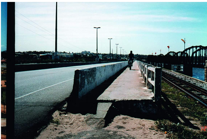
FIGURA 112 CICLISTA EM PASSAGEM LATERAL NA PONTE DO RIO POTENGI
