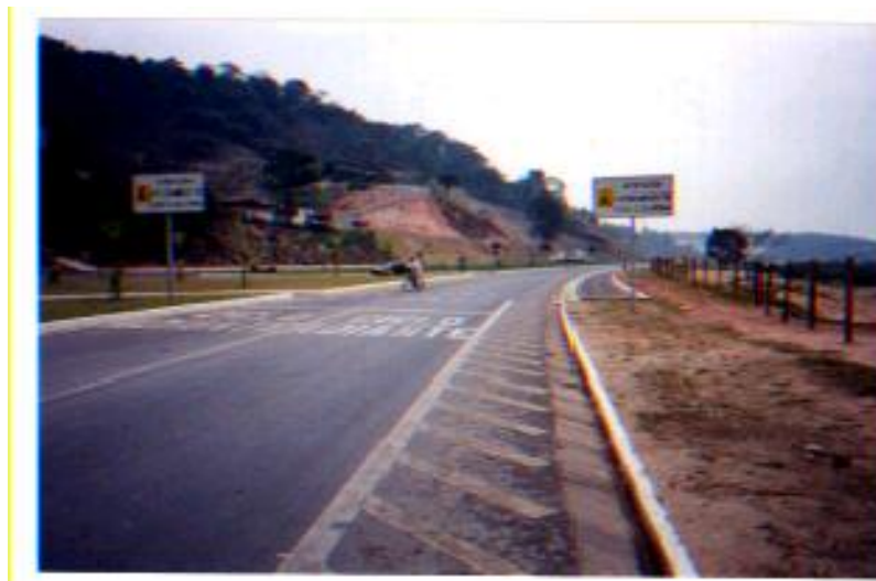
FIGURA 129 SINALIZAÇÃO VERTICAL INDICATIVA DE CRUZAMENTO COM CICLOVIA
